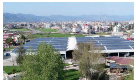
ESPACE DE MARCHÉ D'ANTALYA CENTRALE D'ENERGIE SOLAIRE
